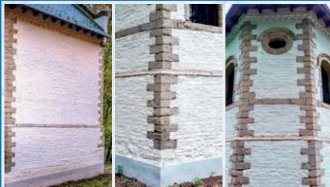
Cordon de pierre en cavet | Chaînage d'angle harpé | Oculus ovale, encadrement des baies sous archivolte, bandeau de pierre, frise dentée au sommet des murs.
