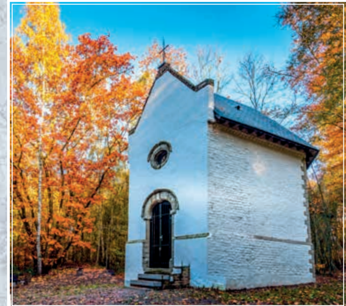
Cordon de pierre en cavet | Chaînage d'angle harpé | Oculus ovale, encadrement des baies sous archivolte, bandeau de pierre, frise dentée au sommet des murs.
